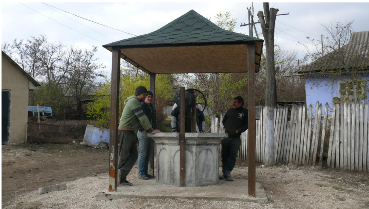
Ferdigstilt brønn med tak
